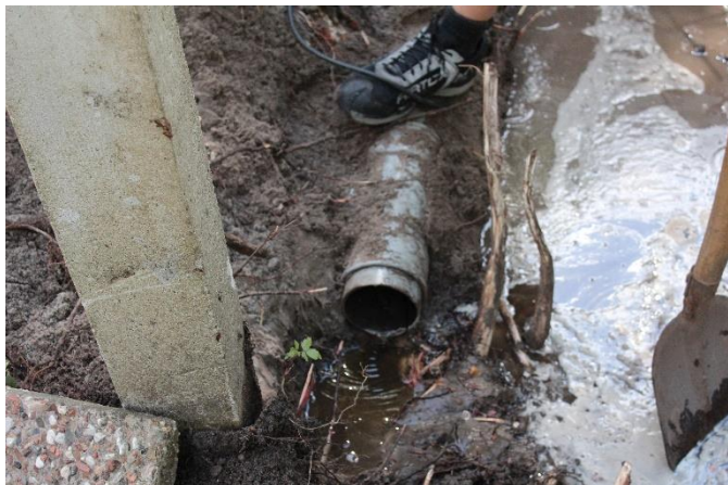
Voor het koppelstuk met de afvoerput, helemaal dicht
